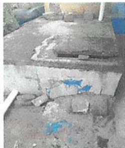
Sustitucion de tanque de concreto por tinaco de 2,500 litros
