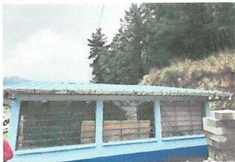
Sustitución de canales de pvc a pvc
