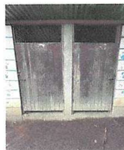
Sustitucion de puertas de madera por puertas de metal servicios sanitarios
