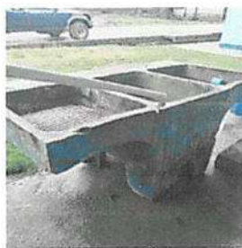
Sustitucion de pila de concreto
