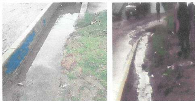
Reparación de manejo de agua pluvial de concreto
