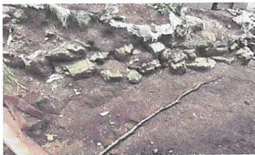
Mantenimiento correctivo con sustitución de muro de piedra
