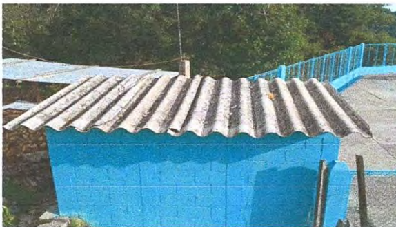
Sustitucion de Lamina, por Lamina Troquelada Calibre 26 en Baños
