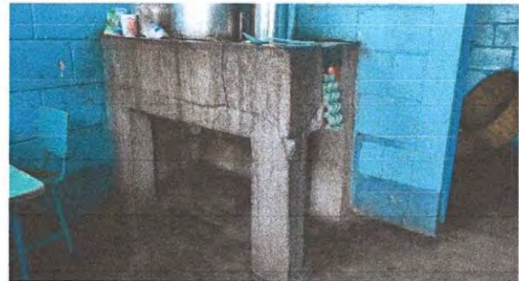
Sustitucion de estufa incluye chimenea metal y azulejo en cocina
