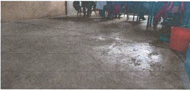
Sustitucion de piso de concreto por Piso Ceramico en Aulas, Cocina, Modulo 1 y Baños
