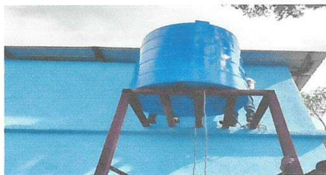
Mantenimiento preventivo (refuerzo de estructura de metal)
