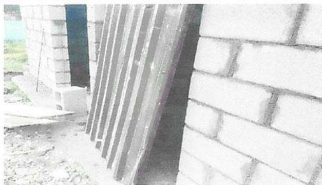
Sustitucion de puertas metalicas en baños
