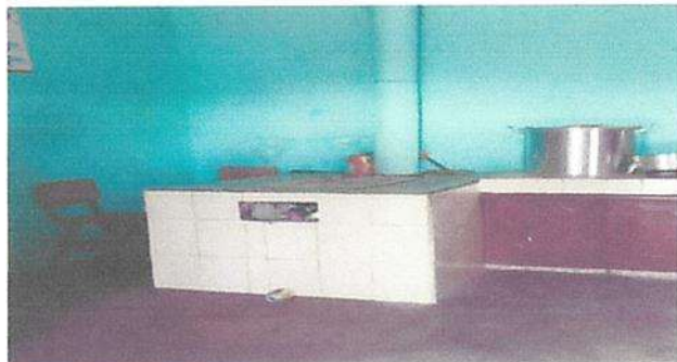
Sustitucion de estufa rural completa (incluye chimenea de ladrillo y plancha de metal) ., Sustitucion de puertas metalicas en baños
