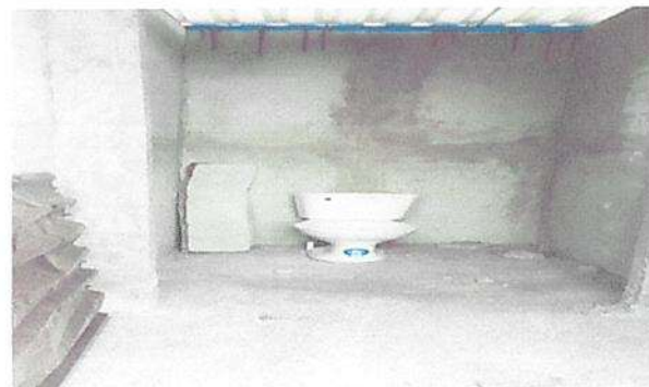
Sustitucion de azulejo en baños
