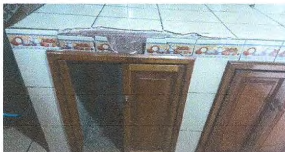
Mantenimiento correctivo de meson de trabajo de concreto en cocina
