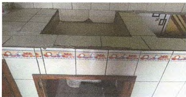
Mantenimiento correctivo de base para lavatrastos en cocina
