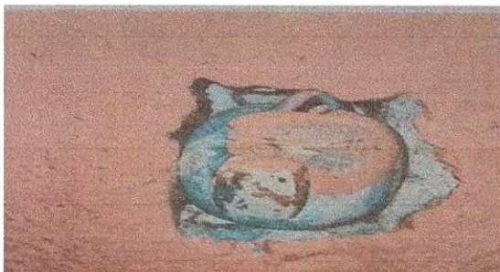
Mantenimiento de sistema eléctrico en cocina
