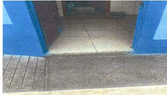
Sustitución de contrapiso de concreto en cocina y patio
