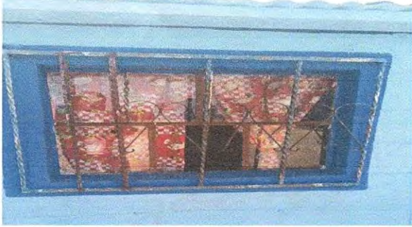
Sustitución de ventana por ventana PVC
