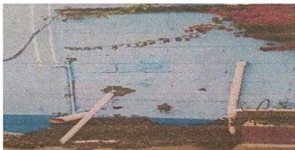
Mantenimiento de paredes con repello y cernido en muro de cocina
