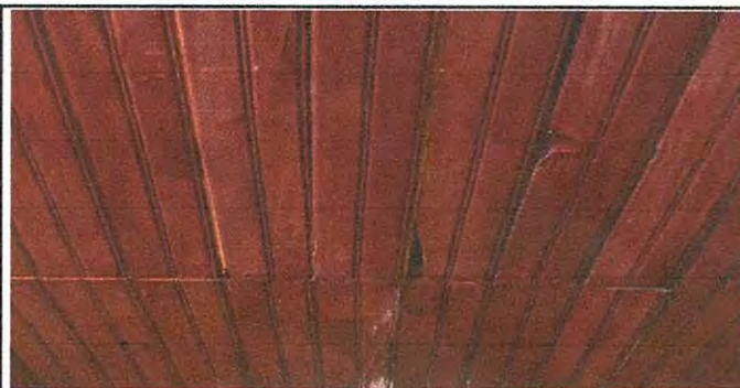
Mantenimiento correctivo de cubierta de cielo falso PVC lavable en cocina
