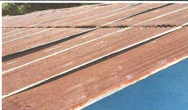
Sustitución de lámina canalada por lámina troquelada calibre 26 en techo de cocina
