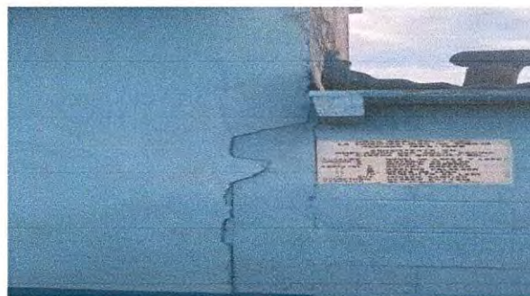
Mantenimiento correctivo en muro con 5 hiladas de block en cocina
