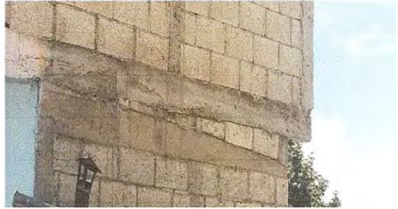
Mantenimiento de muro con Suministro y aplicación de pintura en muros de cocina
