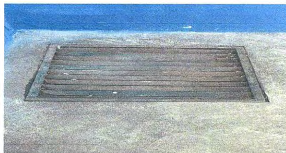
Reparación de caja para agua pluvial en patio
