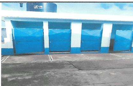
MANTENIMIENTO DE PUERTAS DE METAL PARA BAÑOS. (CAMBIO DE PARTES OXIDADAS, PINTURA, INSTLACIÓN Y AJUSTE DE BISAGRAS). + PINTURA EN PAREDES DE BAÑOS
