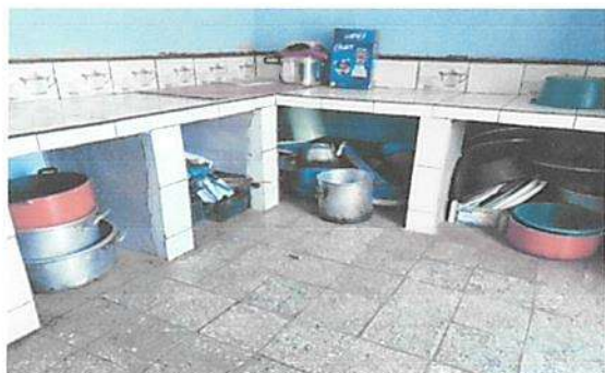
CAMBIO DE PISO DE GRANITO A CERAMICO
