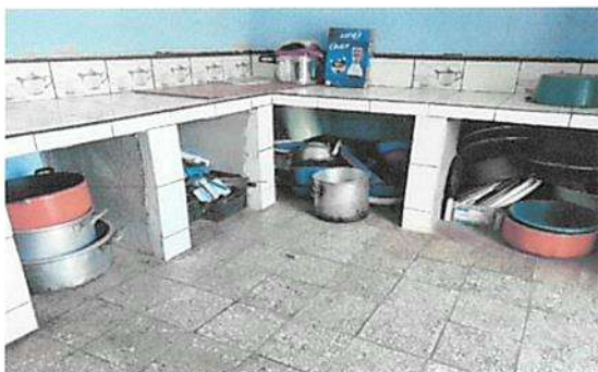
MANTENIMIENTO O REMOZAMIENTO DE GABINETE DE COCINA.
