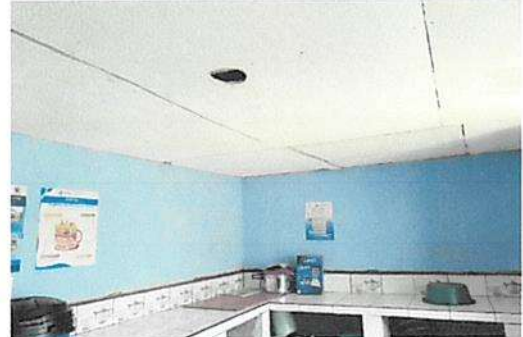
Mantenimiento correctivo de cielo falso para cocina., Sustitución de estufa rural (completa) incluye chimenea y plancha de metal
