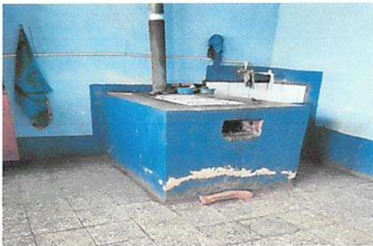
REMOZAMIENTO DE ESTUFA DE LEÑA + CHIMENEA + LAVATRASTOS. (azulejo, chimenea de ladrillo, cambio de plancha)
