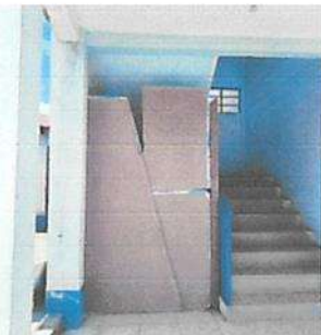
MANTENIMIENTO EN MURO DE BODEGA BAJO GRADAS
