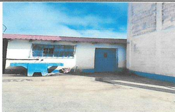
PINTURA DE AULAS, COCINA Y BAÑOS
