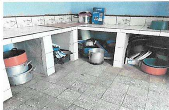
MANTENIMIENTO O REMOZAMIENTO DE PISO DE COCINA
