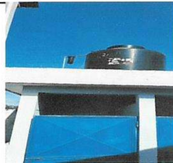
MANTENIMIENTO DE PUERTAS DE METAL PARA BAÑOS. (CAMBIO DE PARTES OXIDADAS, PINTURA, INSTLACIÓN Y AJUSTE DE BISAGRAS). + PINTURA EN PAREDES DE BAÑOS
