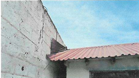
Sustitución de lamina por lamina troquelada calibre 26 color rojo en cocina (suministro)
