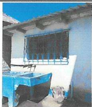
SUSTITUCION DE VIDRIOS Y ESTRUCTURA METALIACA A PVC
