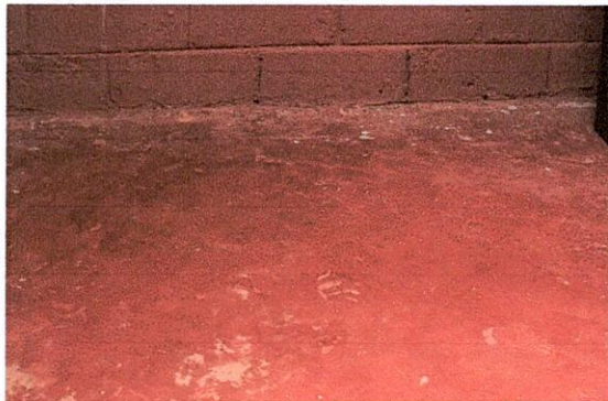
Colocación de piso cerámico en dirección
