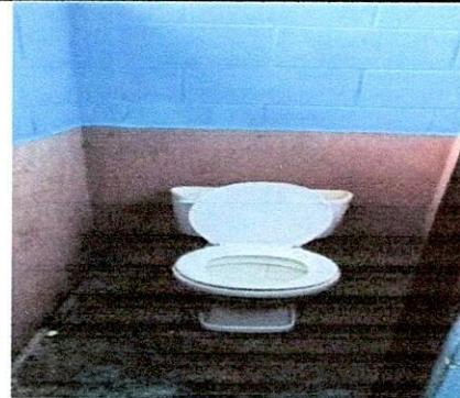
Mantenimiento de tuberías y drenaje en baños.
