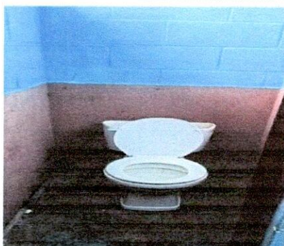
Sustitución de inodoros en mal estado por inodoros elongados en baños.
