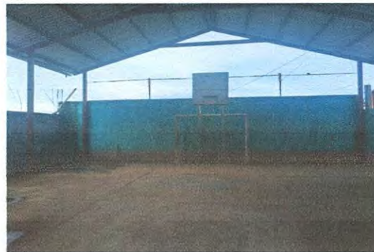
Mantenimiento de bajada de agua pluvial en techo de patio, (Tubo pvc de 3" 80psi blanco y codos de 3")
