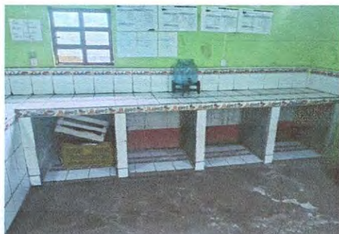
Mantenimiento de gabinetes de concreto: (incluye azulejo, divisiones, puertas y gabinetes de madera), en cocina
