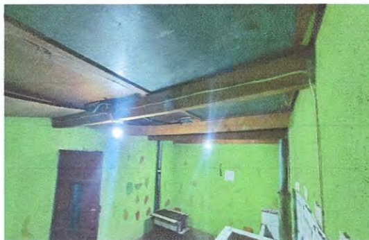
Sustitución de cielo falso de madera en mal estado por cielo falso PVC. En cocina
