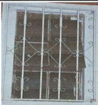
Reparación de balcón de metal en cocina de 1.30*0.90 mts.
