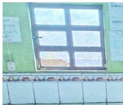
Sustitución y mantenimiento de ventana de metal por ventana de PVC de 1.20*0.80 mts. En cocina
