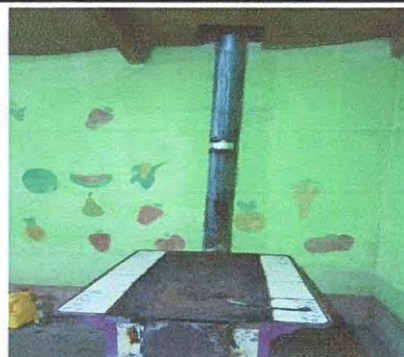
Susutición de tubos y protector para estufa de leña en cocina.
