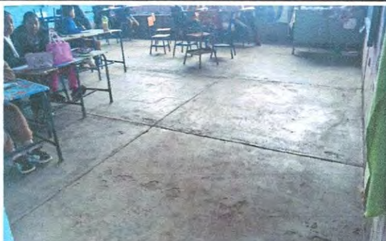
Reparación y nivelación de piso con torta de concreto en cocina, aula y dirección.
