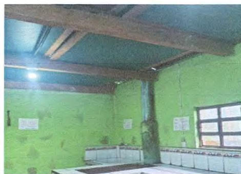
Mantenimiento y aplicación de pintura en paredes de cocina y dirección.
