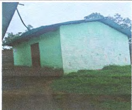
Sustitución de lámina canalada en mal estado por lámina troquelada calibre 26. en techo de cocina.
