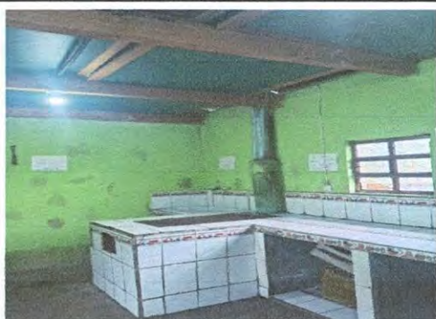
Mantenimiento de energía eléctrica en cocina (2 lamparas, 3 cajss rectangulares, 2 toma corriente, 1 interruptor, 2 tubos de 1/2, cable TSJ).
