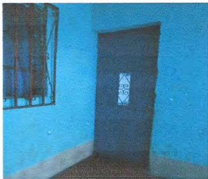
Reparación de puerta de Dirección.
