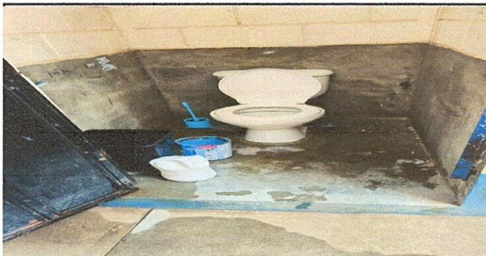
Sustitución de tazas por inodoros elongados (incluye tazas nuevas, bridas y accesorios de grifería)
