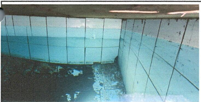
Sustitucion de flote en tanque de agua para baños
