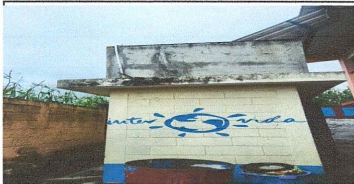
Mantenimiento de muro con Cernido en tanque de agua
