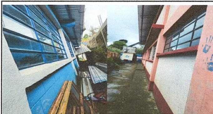
Sustitucion e instalación de balcones en dos secciones de aulas
