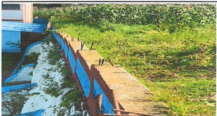
Mantenimiento correctivo en muro perimetral (incluye block, arena, piedrín, hierro, Alambre, madera para fundición).
