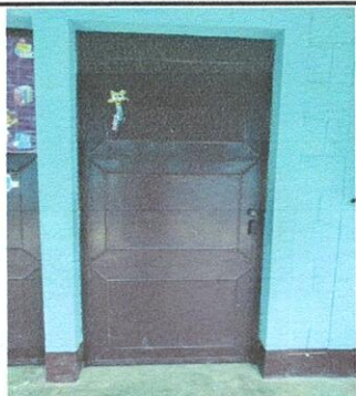
Mantenimiento de estructura metalica en puertas en de modulo 1y2
