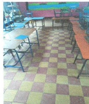
Sustitución de piso de concreto modulo 1 piso mosaico modulo 2 por piso de porcelanato
