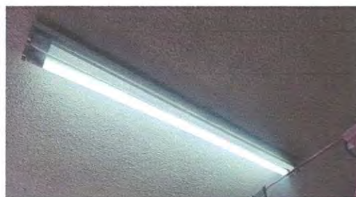
Sustitución de focos, lámpara led de tubo de 18 wats. En los salones de clase
