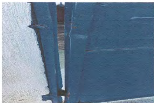
Mantenimiento de portón, entrada principal (incluye lijado cambio de partes dañadas y pintado).
