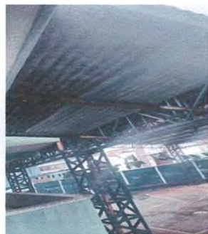
Sustitución de techado de rampa para segundo nivel, reforzado con estructura metálica y lámina troquelada calibre 26
