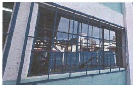
Mantenimiento de estructura metálica en mal estado en puertas, (incluye lijado y pintado) de los salones de clase de modulo 1
