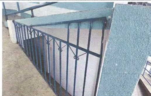
SUSTITUCIÓN DE BARANDA EN RAMPA DE SEGUNDO NIVEL
