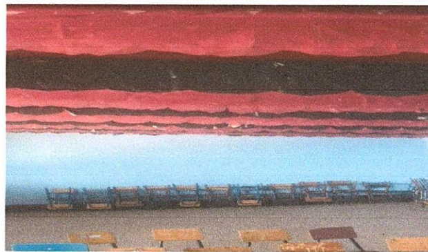
Mantenimiento correctivo de cielo falso de PVC en el salón
