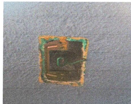
Mantenimiento de sistema eléctrico (10 lámparas y 12 tomacorrientes.) para el salón
