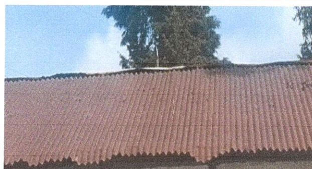
Sustitución de capote de lámina Maxalum para la lámina para un canal
