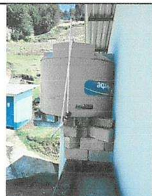
sustitucioin de deposito de 1,100 lts en cocina
