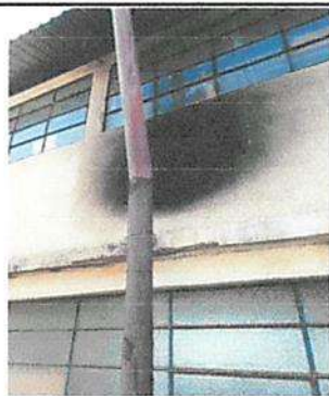
Mantenimiento y sustitucion de chimenea de metal por ladrillo
