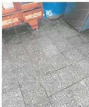
Sustitucion de piso de concreto por piso ceramico en cocina
