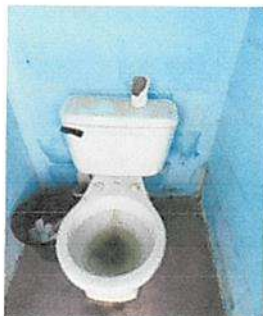
sustitucion de inodoros elongados
