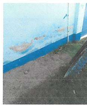
Mantenimiento de pintura del edificio escolar (aulas, baños y pasillos)
