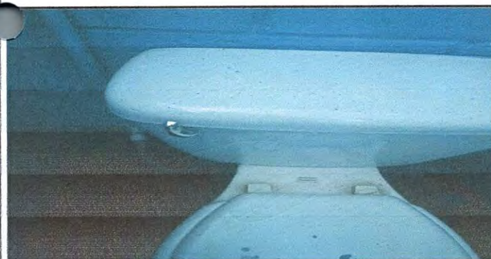
Mantenimiento de tazas sanitarias (incluye accesorios)
