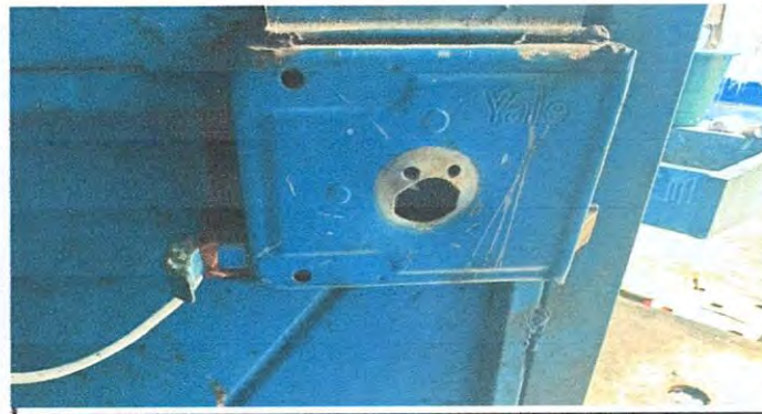
Sustitución de chapas en mal estado por chapas yaye
