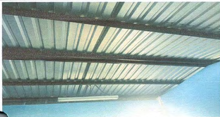
Reparación de cubierta de cielo falso de PVC en 2 aulas y dirección
