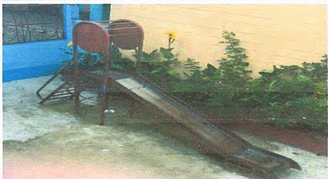
Mantenimiento de pintura en mal estado de resbaladero en el área de juegos.
