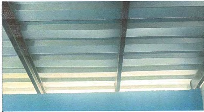
Reparación y rellenado de agujeros en solera en dos aulas y dirección
