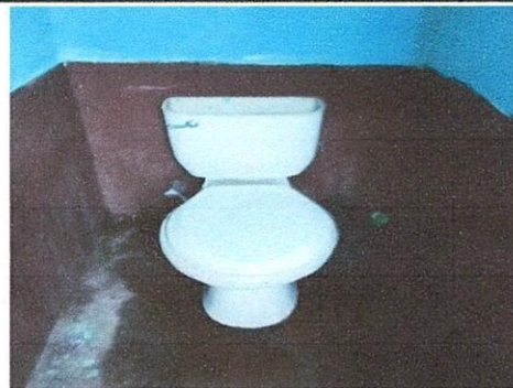
sustitución de 4 inodoros (tasas de baño)
