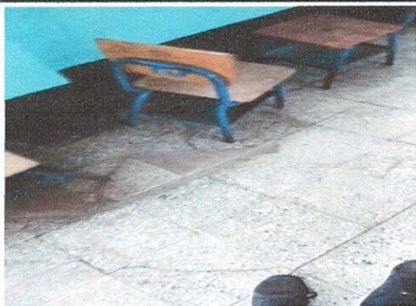
Sustitucion de piso ceramico por piso porcelanato en aulas de modulo 1
