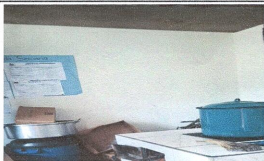
sustitucion de cielo falso de machimbre por PVC en la cocina
