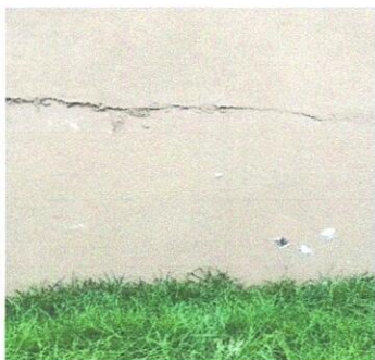
matenimiento y aplicación de repello cernido en una aula del modulo 1
