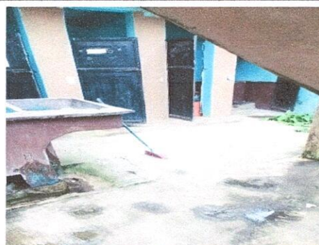
Sustitucion de linea de Drenaje de baños con tubo pc 4" en baños.
