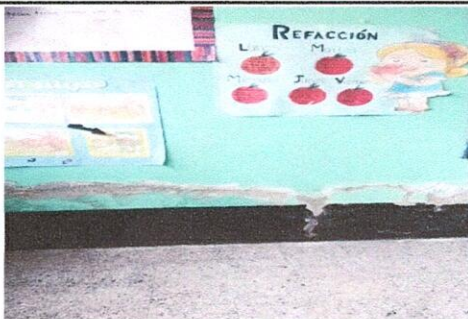
Mantenimiento de muros con suministro y aplicación de Pintura interior en paredes de aulas en el modulo 1.
