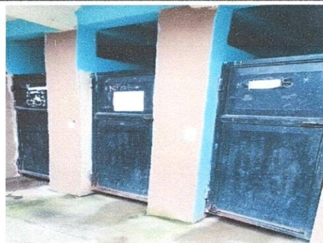
mantenimiento de puertas metalicas(pintado,lijado) en los baños
