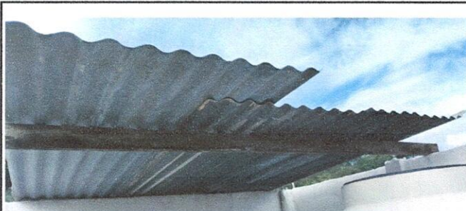
Sustitucion de lamina ondulada por lamina troquelada en lavadero.
