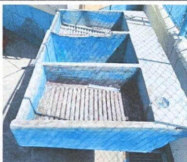
sustitucion de pilas de concreto de modulo 1
