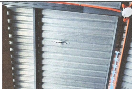
sustitucion de laminas troquelada por lamina caliubre 26 en aula modulo
