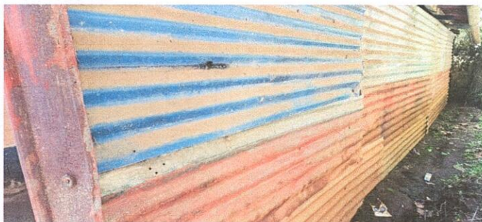
Sustitución de cerco perimetral con tubo hg y malla galvanizada en modulo 2 , Sustitución de lamina troquelada por lamina troquelada calibre 26 en aula de modulo 2
