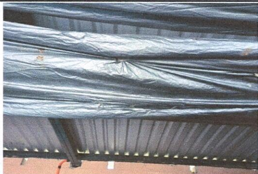
mantenimiento correctivo con sustitucion de cielo falso dirección y salon modulo 2
