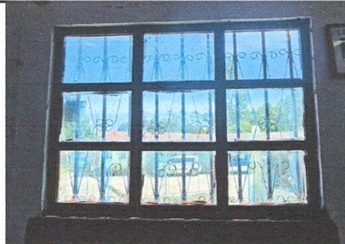
sustitucion de estructura de ventanas de madera por upvc en aulas de modulo 1
