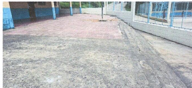
Mantenimiento correctivo de planchas de concreto en cancha de modulo 1
