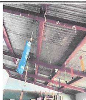
Reparación de cableado calibre 12AWG mas poliducto (sobrepuesto).
