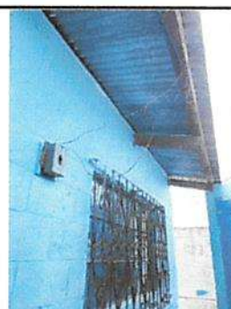
Sustitución tablero principal 4x110
