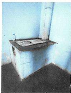
Sustitución de estufa rural completa, incluye chimenea tubo de concreto y plancha de metal en cocina.
