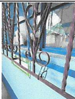
Mantenimiento a balcones de metal en aula 1 del modulo 2
