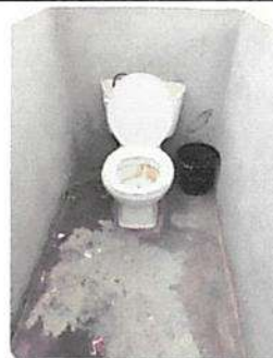
Sustitución de inodoro elongado
