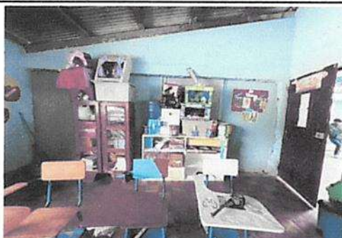
Sustitución de Pared Divisoria de tabla yeso en aulas 1 y 2 de modulo 1
