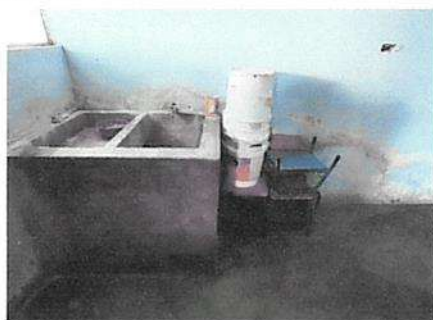
Sustitución de lavatrastos de concreto en cocina
