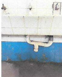
Sustitución tubo de abasto lavamano baño de niños
