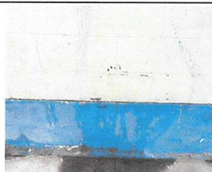
Suministro de aplicación pintura interior latex lavable(limpieza, resane y aplicación)
