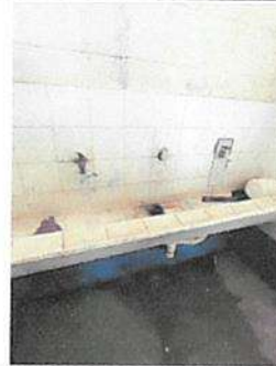
Sustitución Grifería en Lavamanos
