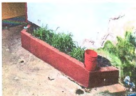
sustitución de azulejo en muro de jardín
