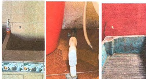
Sustitución de línea de agua potable en cocina, baños y pila.
