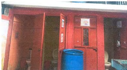
sustitución de inodoros por inodoros elongados.
