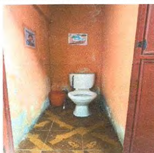
Sustitución de piso ceramico por piso ceramico en baños.
