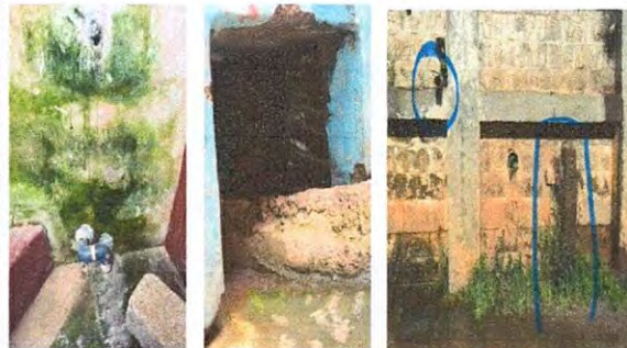
Reparación de línea de drenaje en cocina y pila
