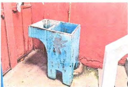
Sustitución de pila con azulejo de 1*0.65*80 MTS.
