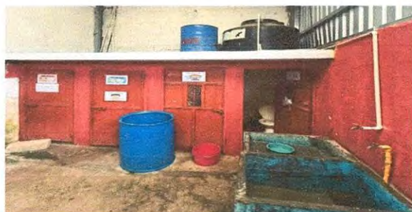
Sustitución de deposito de agua de 2500 lts. Y accesorios para instalación.
