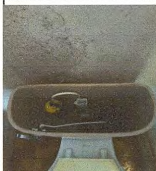
sustitución de accesorio de inodoros , contra llave y tubo de abasto.
