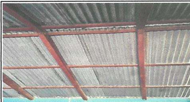
Sustitución de lamina, por lamina traslucida troqueleada calibre 26
