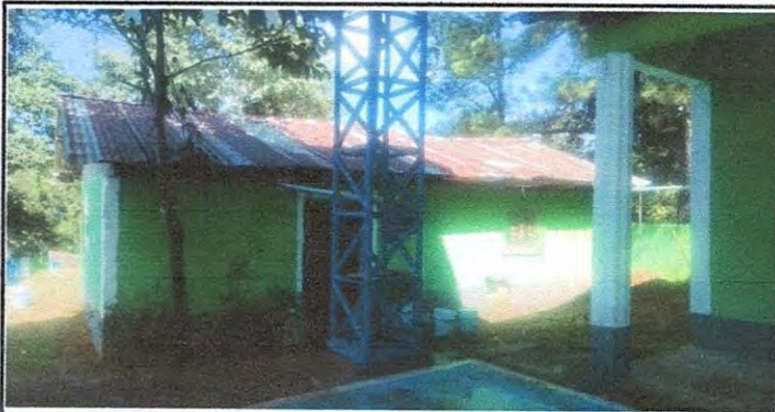
Sustitucion de techo de aula de 2 aguas con lámina calibre 26 troquelada incluye estructura metaliza.
