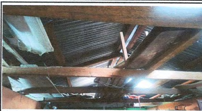
Sustitucion de estructura de soporte de madera por Estructura metalica para techo de dos aguas con costanera de 3x2 dobles, Tendaes de constanera de 3x2
