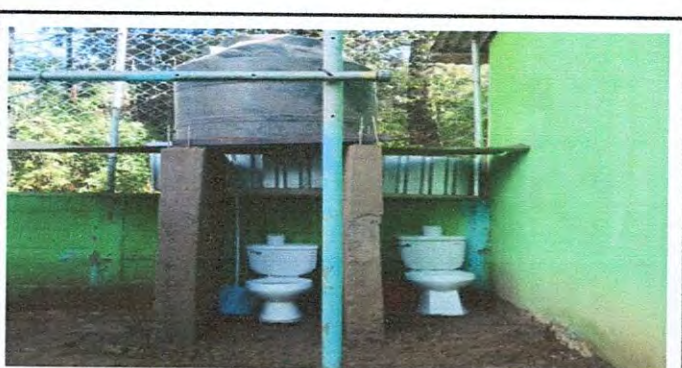
Sustitucion de inodoros sanitarios (incluye instalacion y accesorios)
