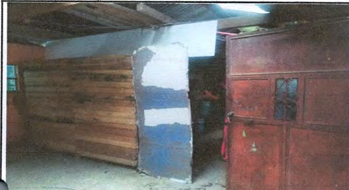
Mantenimiento correctivo con sustitución de División de madera por tablayeso de dos caras en (direccion)
