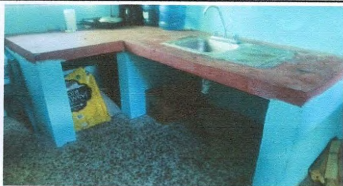
Mantenimiento correctivo con instalacion de Puertas para mesa de trabajo.
