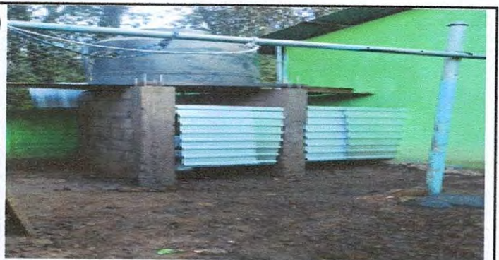
Mantenimiento correctivo de linea de Drenaje con sustitucion de tubo de 3" en sanitarios.
