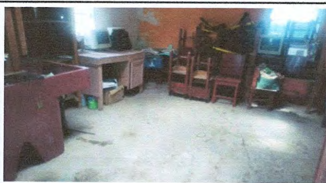
Sustitucion de Piso de concreto en el area de direccion
