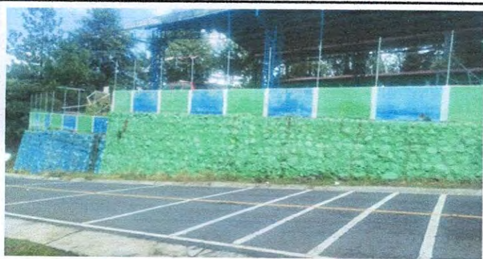
Mantenimiento preventivo de muro con suministro y aplicación de Pintura exterior para fachada (pintura lavable plus drywall)
