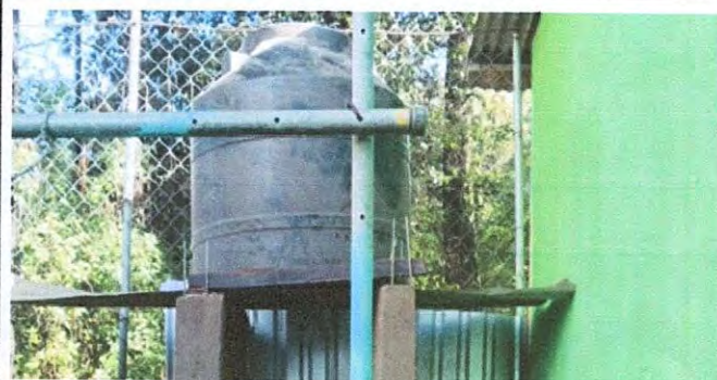
Sustitucion de estructura de madera por estructura de metal para soporte de tinaco de tubo de 3 x3c ch 16 de 1.50 x1.50
