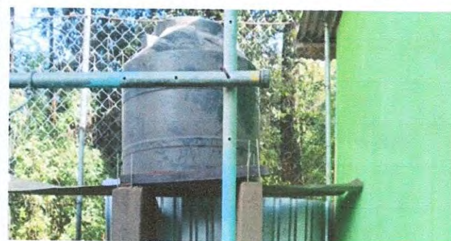
Sustitucion y Suministro e instalacion de tinaco de 1700 litros.
