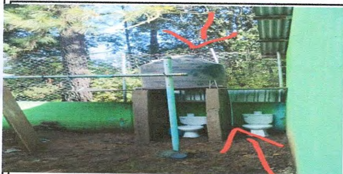
Sustitucion y Suministro e instalación tubería para agua potable dirigida a tinaco con accesorios.
