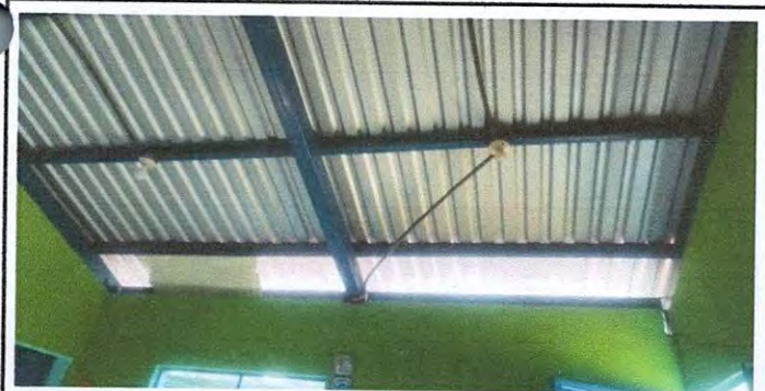
Mantenimiento correctivo con Sellado de muro y techo de cocina en cocina.
