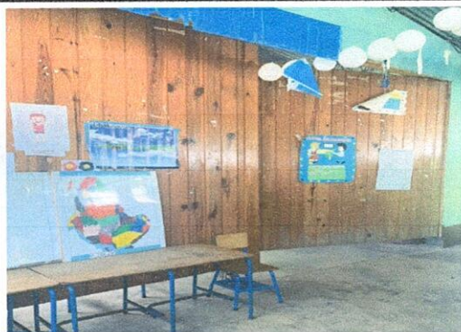
Mantenimiento correctivo de muros con suministro e instalacion de paredes, de tablayeso en aulas de modulo 1
