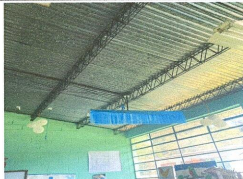
Reparación de cubierta con cielo falso de PVC en aulas de modulo 1
