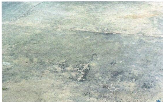
Sustitución de piso de concreto a piso ceramico en aulas de modulo 1
