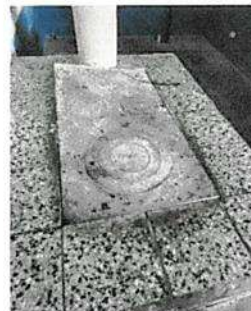
Sustitución de plancha de leña completa y incluye chimenea de ladrillo y plancha de metal
