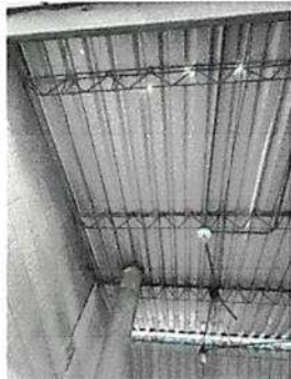
Sustitucion de lamina troquelada calibre 26 de la cocina
