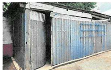
Mantenimiento preventivo de aula con longitud, 6.20 m de largo, 3.50 m de ancho, mantenimiento de pared con durok forrado con tabla yeso, repellado y blando por fuera.
