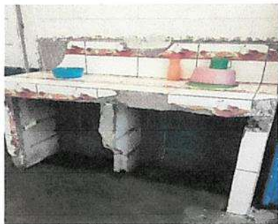
Mantenimiento correctivo de mesa de trabajo de concreto en cocina.
