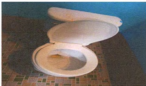
Sustitución inodoro elongado
