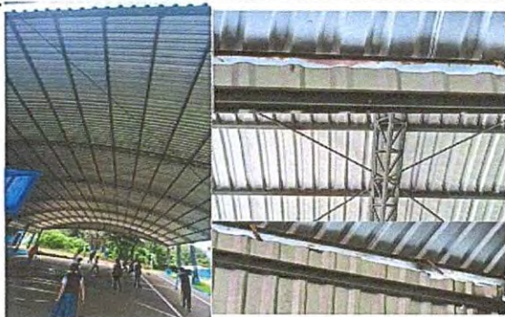
Mantenimiento a estructura de soporte de metal anticorrosivo en techo de la cancha ( lijado y pintura)
