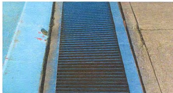
Mantenimiento de rejilla de metal en cancha ( lijado y pintura)
