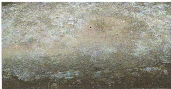
Mantenimiento de piso de concreto en patio
