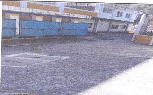
Mantenimiento de Puertas: Mantenimiento a estructura, lijado, cambio de tubo, cepillado y aplicación de pintura
