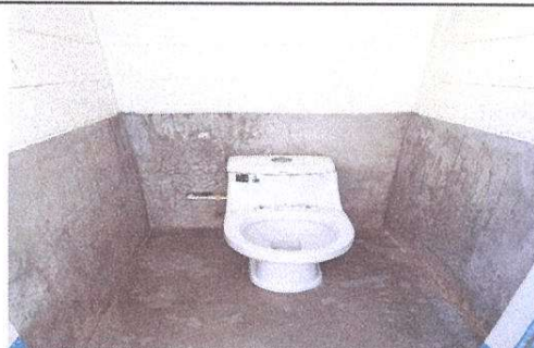
Sustitución de azulejo para baños
