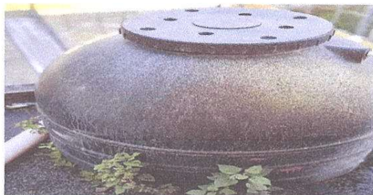
Sustitución de depósito de agua 1000 litros
