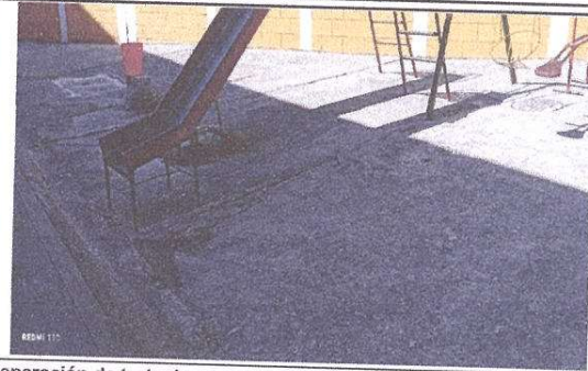
Reparación de torta de concreto con piso cerámico para exteriores
