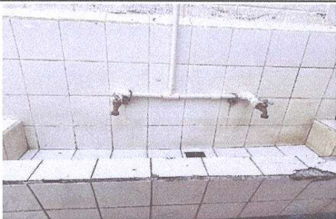
Sustitución de lavamanos
