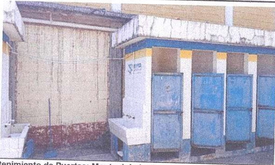
Mantenimiento de Puertas: Mantenimiento a estructura, lijado, cambio de tubo, cepillado y aplicación de pintura
