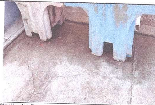
Sustitución de pila
