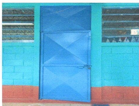
Mantenimiento de Puertas metalicas incluye (lijado, cortada y pintado)
