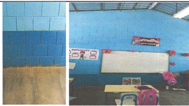
Mantenimiento de muro con Suministro y aplicacion de pintura interior SHERWIN WILLIAMS de agua para pared y aceite para zócalo en aulas de modulo 1.
