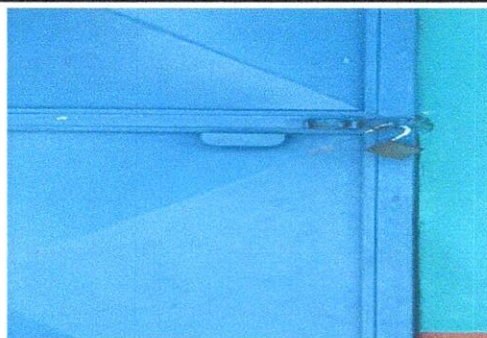
sustitucion de candado a chapas yale en puertas de aulas de modulo1.
