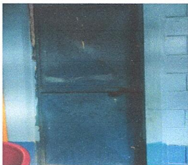
Sustitucion de puerta en mal estado por puerta metalica en area de cocina.
