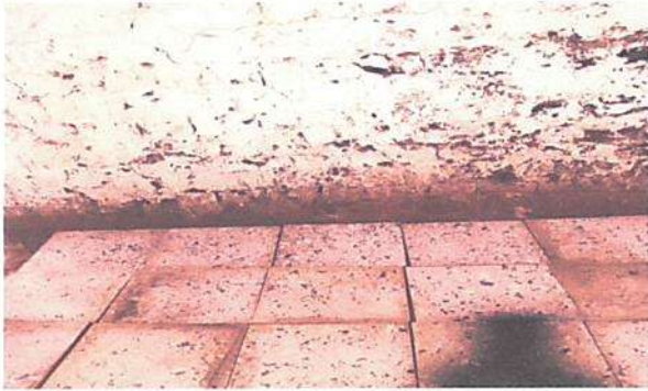
SUSTITUCION DE PISO DE CONCRETO A CERAMICO EN COCINA
