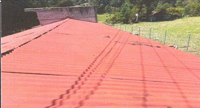
Sustitución de lámina, por lámina troquelada color rojo calibre 26 de 14 pies
