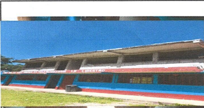
Suministro y aplicación pintura exterior latex celeste Pantone 293 para aulas
