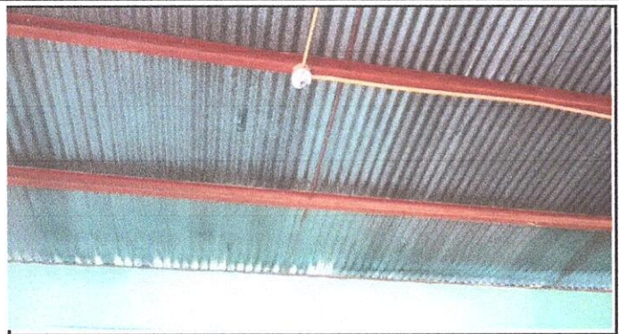
Reparación de Costaneras 3x2
