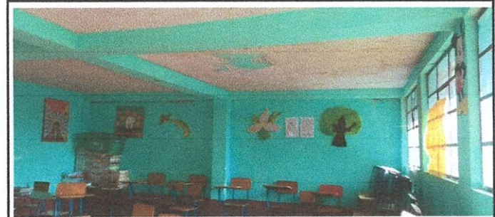
Suministro y aplicación de pintura latex interior color aqua Pantone para aulas
