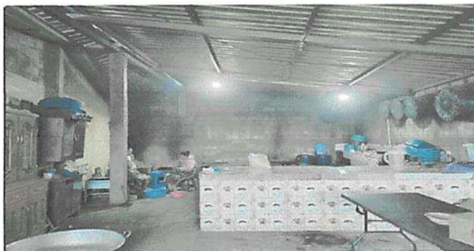
Reparación de mesa de concreto y colocación de azulejo.
