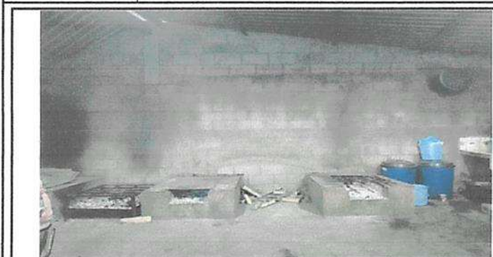
Repello de pared en cocina y sustitución de piso de concreto a cerámico en cocina
