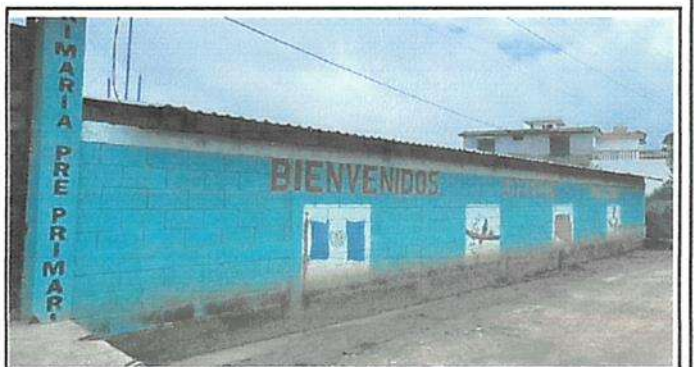
Repello de muro exterior.
