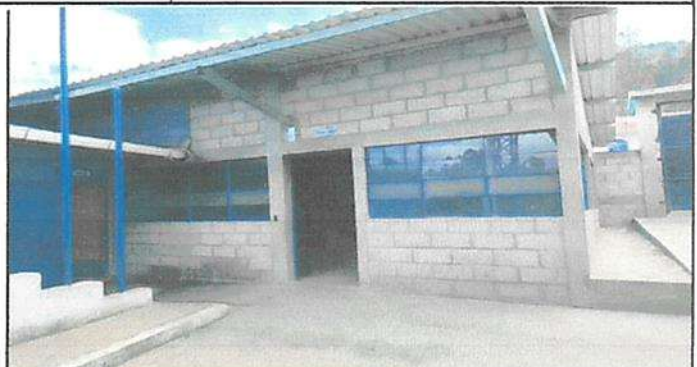
Repello exterior de cocina.
