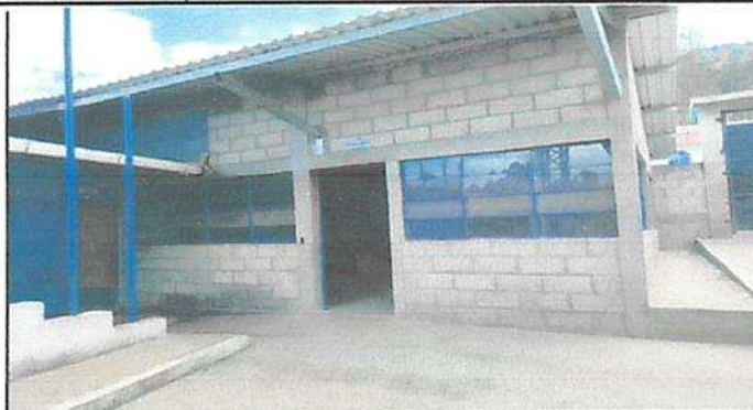
Repello exterior de cocina.
