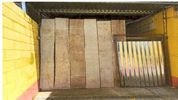
Sustitución de division por durock (3.60 mts X 2.60 mts) usg 1/2X4X8 y pintura en direccion del módulo 1
