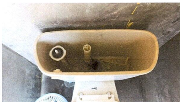
Sustitución de accesorios de tanque de inodoro en baños del modulo 1 (válvula de llenado, flaper de caucho, flotador de tanque)
