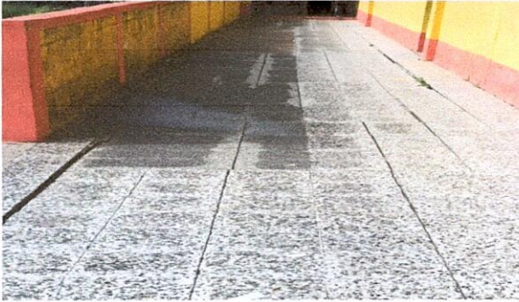
Mantenimiento correctivo de pasillo (nivelación y compactación) de suelo previo a la colocación de torta de concreto en módulo 2
