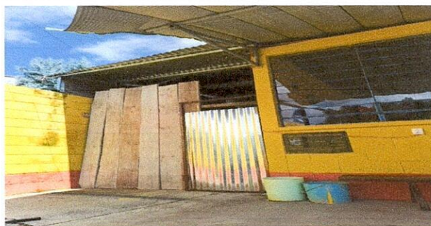
Sustitución de puerta (2.00 mts X 1.00 mts) de metal en direccion del módulo 1
