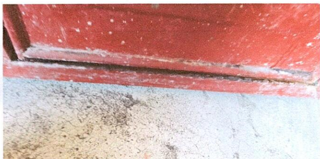
Sustitución de puerta de metal por puerta de metal en cocina módulo 2, (2.30 mts X 1.00 mts)
