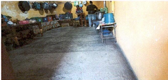
Mantenimiento correctivo a piso en cocina módulo 2 con torta de concreto e=0.05 mts previo a la colocación de piso cerámico
