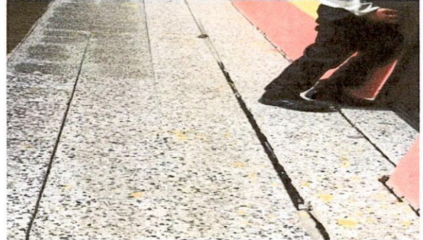
Sustitución de piso granito a plancha de concreto con e=0.10 mts en area de pasillo módulo 2 y área recreativa en módulo 1
