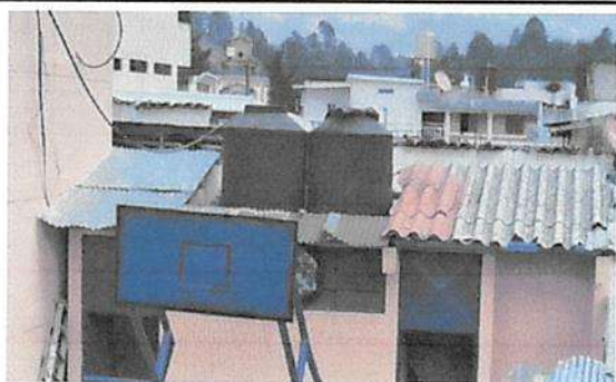
Sustitucion de lamina en techo de servicios sanitarios y rampa
