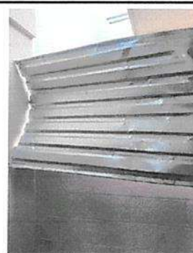
Sustitucion de balcones
