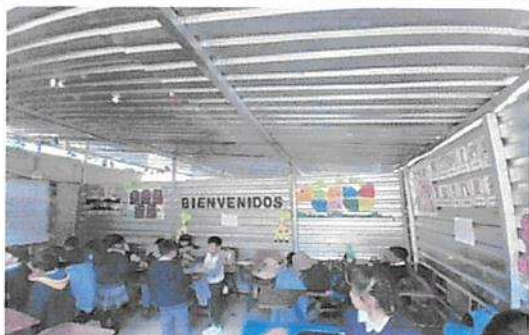
Sustitucion de divisiones de lamina por divisiones de durock
