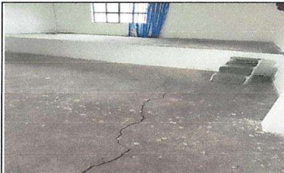
Mantenimiento de piso de concreto del salón con suministro de materiales
