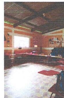
Foto 4: Sustitución de lámina acanalada por lámina troquelada calibre 26 en dirección, módulo 1, módulo 2, módulo 3, módulo 4, módulo 5, bodega
