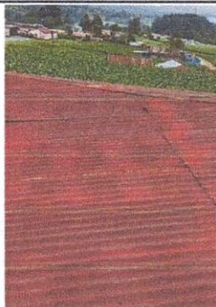
Foto 3: Sustitución de lámina acanalada por lámina troquelada calibre 26 en dirección, módulo 1, módulo 2, módulo 3, módulo 4, módulo 5, bodega
