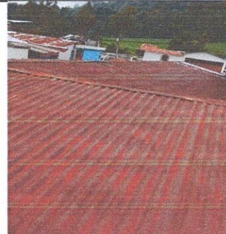
Foto 2: Sustitución de lámina acanalada por lámina troquelada calibre 26 en dirección, módulo 1, módulo 2, módulo 3, módulo 4, módulo 5, bodega
