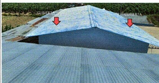
Mantenimiento de cubierta de lámina con pintura anticorrosiva modulo B
