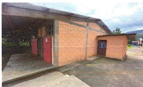
Aplicación pintura exterior látex celeste pantone 293 para muros
