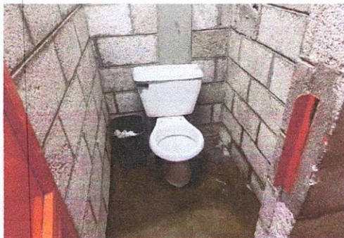
Sustitución inodoros una pieza blanco elongado descarga doble agua con accesorios (mangera, llave, accesorios de tanque)
