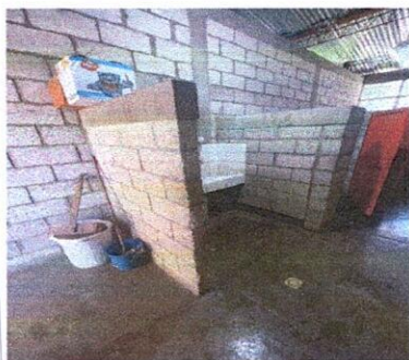
Suministro e instalación de cabinas de sanitarios prefabricada de tabla roca (ajuste de paredes)
