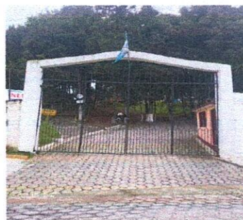
Sustitución de portón de metal
