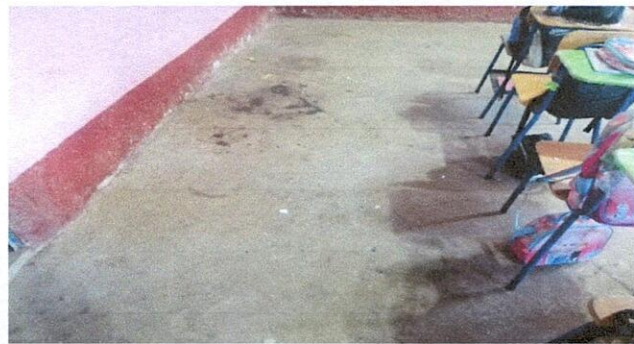
sustitución de piso de concreto a piso porcelanato en aulas de modulo 3
