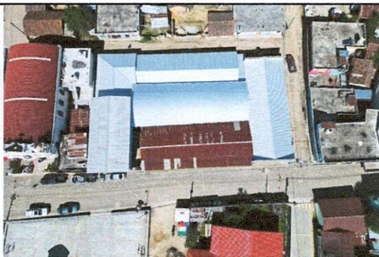
sustitución de lamina acanalada por lamina maxalum calibre 26 en modulo 2
