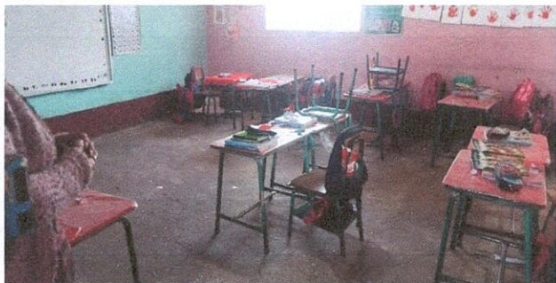
sustitución de piso de concreto a piso porcelanato en aulas de modulo 3
