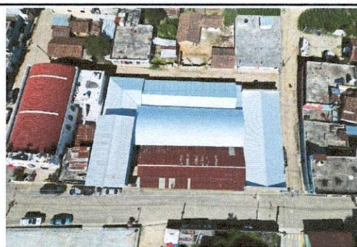
sustitución de lamina acanalada por lamina maxalum calibre 26 en modulo 2
