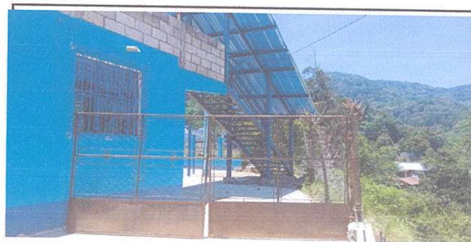
Sustitución de portón
