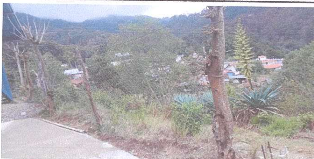
Sustitucion de malla a estructura metálica
