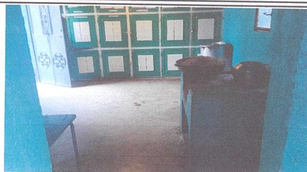
Sustitución de piso de concreto a piso porcelanato en aulas y cocina
