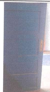
Sustitucion de puertas de madera a puertas de metal
