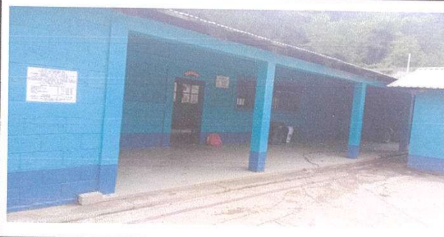
Sustitución de piso de concreto a Duela Parana gris en pasillo
