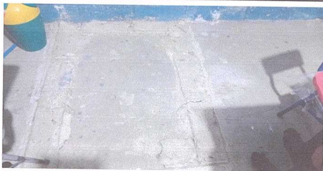
Sustitución de piso de concreto a piso porcelanato en aulas y cocina
