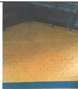
Repello en muros de cocina
