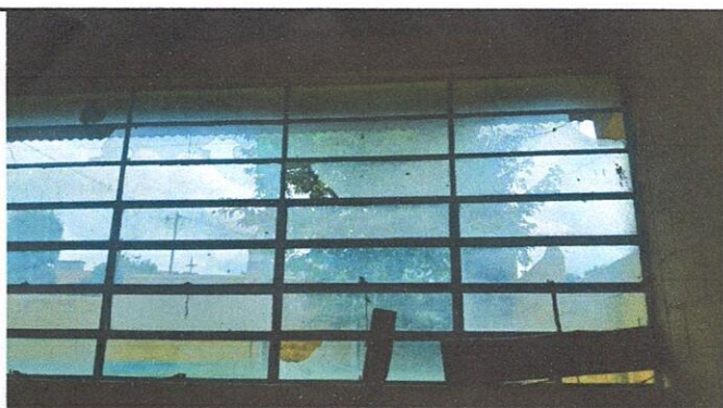
Sustitución de ventanas de PVC corredizas.
