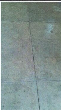
Sustitución de piso de concreto pulido por piso porcelanato en cocina
