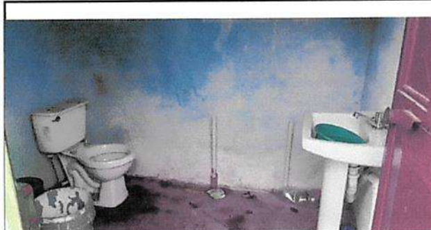
Sustitcion de Sanitarios
