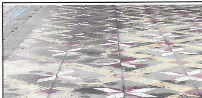
Sustitución de piso por porcelanato
