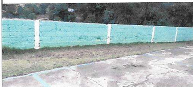
Suministro y aplicación de pintura
