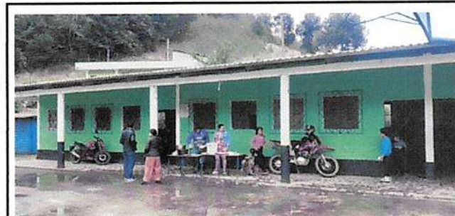
Suministro y aplicación de pintura
