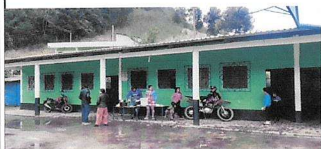
Instalación de canal de metal
