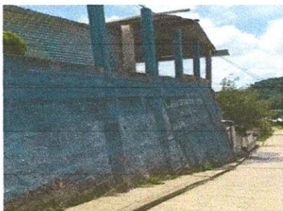
Sustitución de columnas h = 2 m con hierro corrugado Ø 1/2" grado 40, para cerramiento con malla en muro de contención
