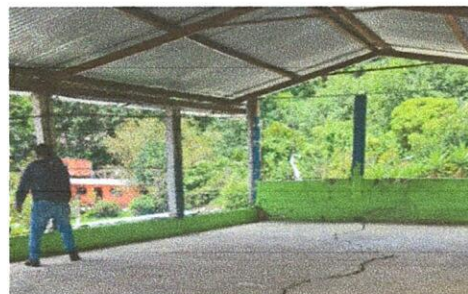
Fotografía de la Parte Superior del Muro
