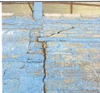
Sustitución de muro de contención a una H = 4 metros arriba del nivel del suelo, de block pineado con refuerzo de columnas y 4 soleras intermedias con hierro corrugado de Ø1/2" grado 40
