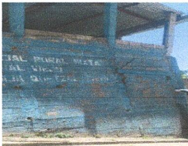
Sustitución de muro de contención a una H = 4 metros arriba del nivel del suelo, de block pineado con refuerzo de columnas y 4 soleras intermedias con hierro corrugado de \varnothing 1/2" grado 40
