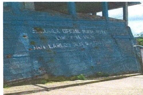
Sustitución de muro de contención a una H = 4 metros arriba del nivel del suelo, de block pineado con refuerzo de columnas y 4 soleras intermedias con hierro corrugado de \varnothing 1/2" grado 40
