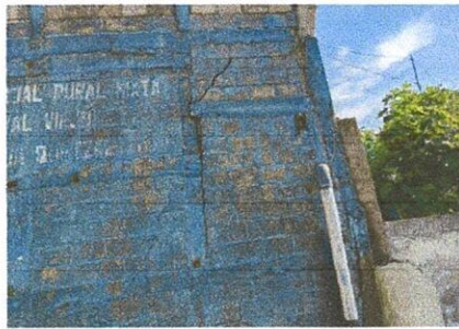
Sustitución de muro de contención a una H = 4 metros arriba del nivel del suelo, de block pineado con refuerzo de columnas y 4 soleras intermedias con hierro corrugado de Ø1/2" grado 40
