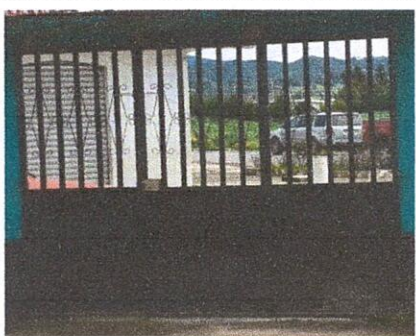
Mantenimiento de portones metálicos (lijado y pintura)
