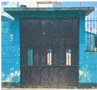
Repello columnas en portones de entrada principal del Centro Educativo.
