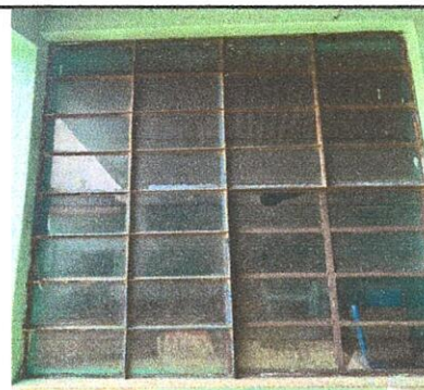
Sustitución de balcón de metal en ventana de cocina
