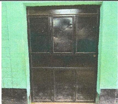
Mantenimiento de puertas metálicas (lijado y pintura)
