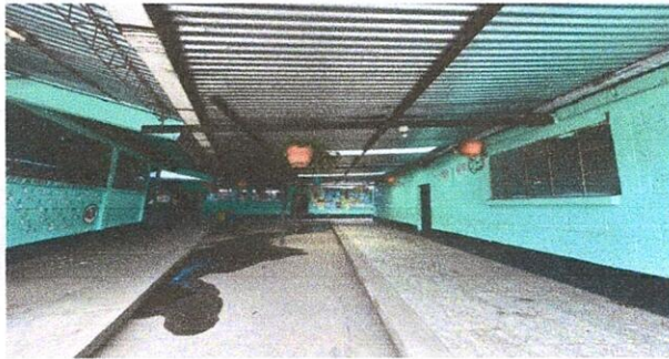
Aplicación de repello exterior en aulas y salón.
