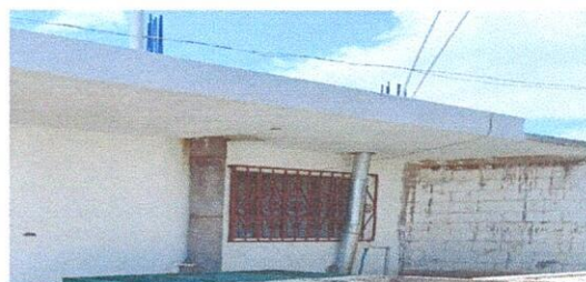
Sustitución de tubos de chimenea por ladrillos tubulares
