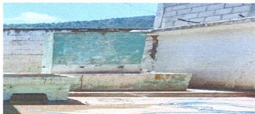
Sustitución de depósito de concreto por deposito de agua de 1100 lts
