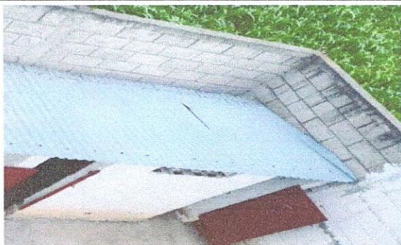
Sustitución de techo de lamina en letrinas
