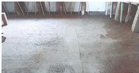
Sustitución de piso concreto a duela de cerámico en cocina
