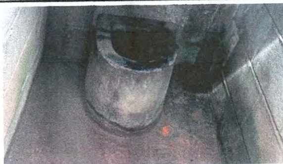
Sustitución de 3 sanitarios elongados y accesorios
