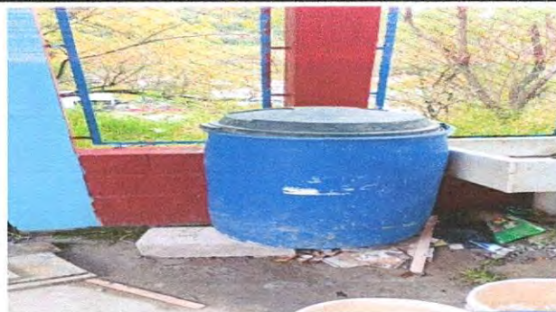
Sustitución de depósito de agua 1100 lts para baños y estructura de metal
