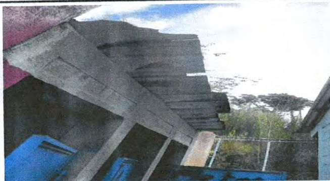
Suministro e instalación de estructura portante de metal de 8m2 para lámina troquelada en baños
