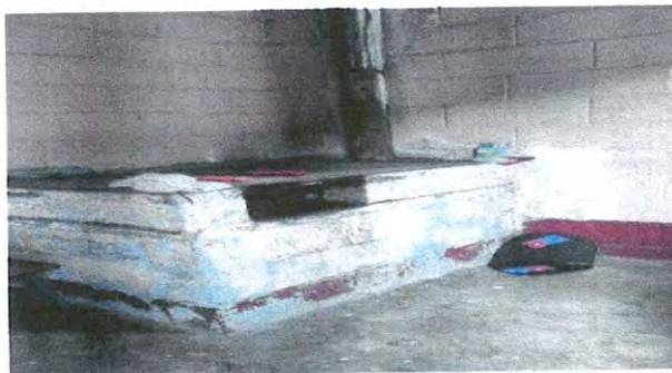
Sustitución de Plancha en cocina de 1.30 mts X 1.00 mts X 0.90 mts con chimenea y plancha de metal
