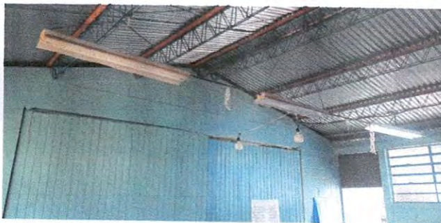
Sustitución de 17 lamparas a lamparas LED 30W 2400 Lumines
