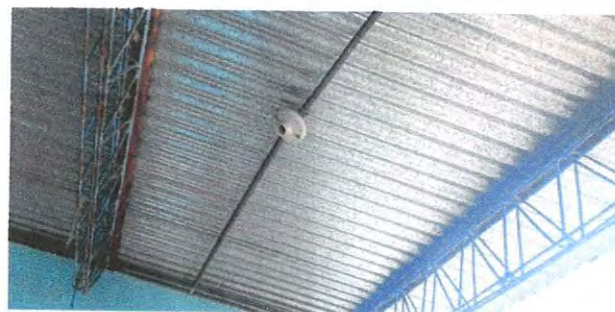
Sustitución de 17 plafoneras, aulas cocina y pasillos
