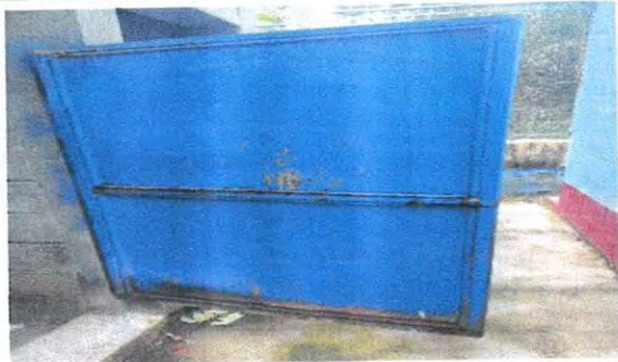
Sustitución de 3 Puertas de Metal en baños con aplicación de pintura anticorrosiva color azul
