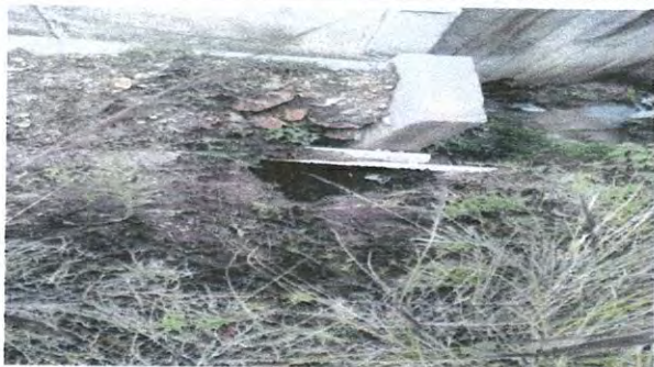
Sustitución de 30 ml de tubería de PVC línea principal de aguas negras de 4" de los baños
