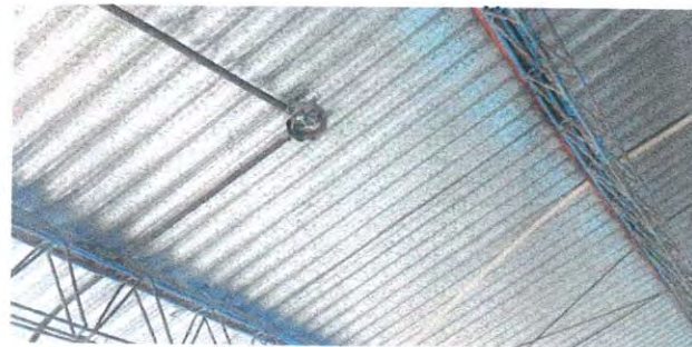
Reparación de 196 ml cableado eléctrico Calibre 10 AWG aereo y sobrepuesto en aulas cocina, pasillos, con tubería de protección.
