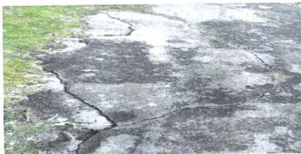
Suministro de torta de concreto de 115 m2 en área de patio con e=0.10 mts
