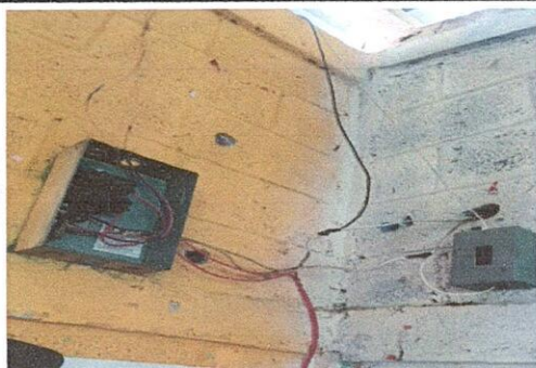
Mantenimiento de electricidad, cable calibre 10, plafoneras, tomacorrientes, caja de dados, focos.
