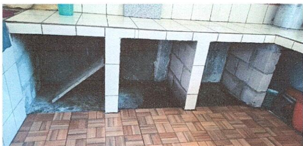
MSustitución de puertas de gavinetes a puertas de madera en la cocina
