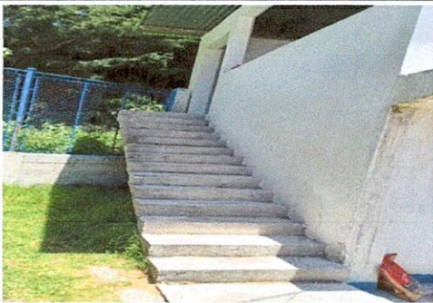
Sustitución de piso de concreto por piso antideslizante en las gradas de la dirección
