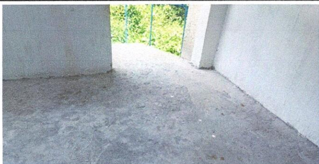
Sustitución de piso de concreto por cerámica en la dirección
