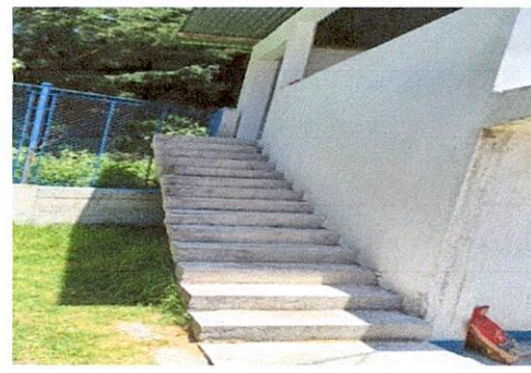
Mantenimiento correctivo para protección de gradas de dirección con barandas
