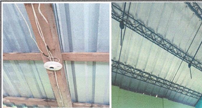
Mantenimiento de electricidad, cable calibre 10, plafoneras, tomacorrientes, caja de dados, focos.
