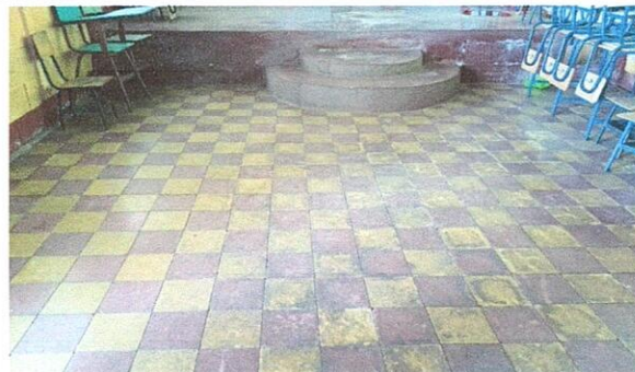
Matenimiento y sustitución piso concreto y mosaico para 3 aulas.
