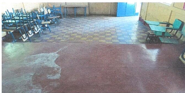
Matenimiento y sustitución piso concreto y mosaico para 3 aulas.
