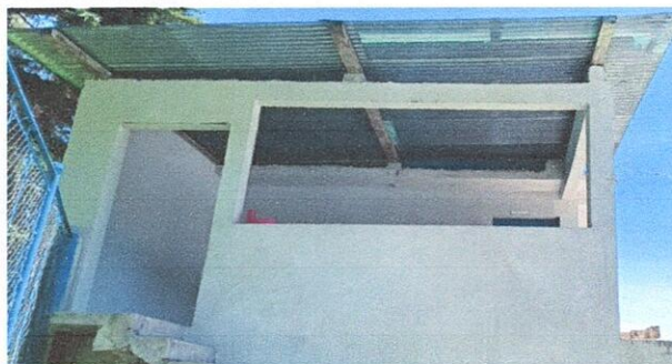
Sustitución de vigas de madera por costaneras de metal de 6 m
