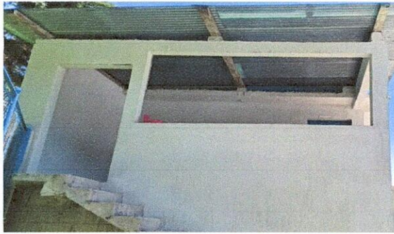
Sustitución de puerta en dirección
