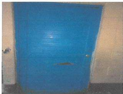
Sustitución de puertas aulas y cocina
