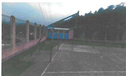
Sustitución de pintura en toda la escuela
