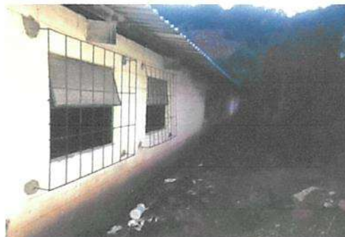
Repello de aulas y paredes
