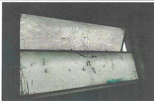
Sustitución de ventanas
