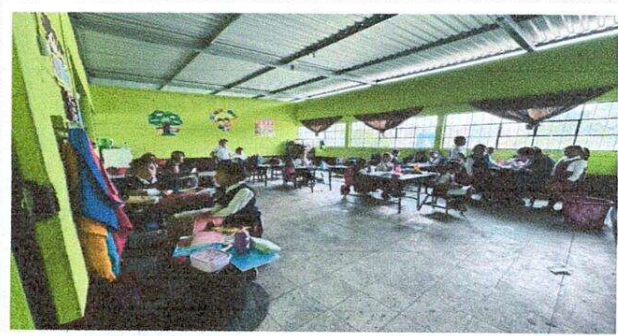
Sustitución de piso a piso granito para aulas y pasillo
