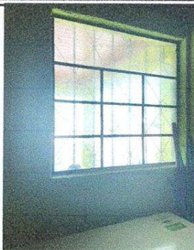
Sustitucion de ventana en cocina
