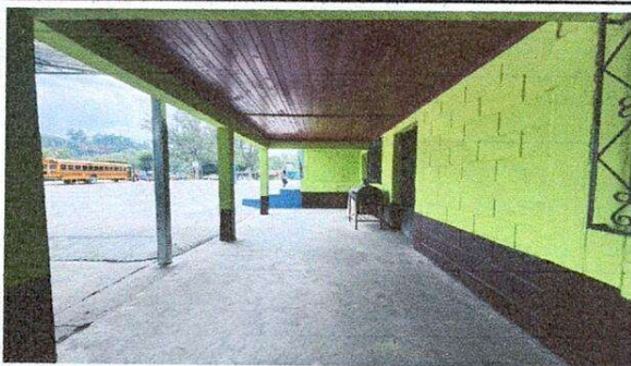
Sustitución de piso a piso granito y pasillo
