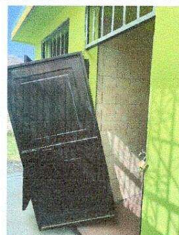
Sustitucion de puertas de servicios sanitarios
