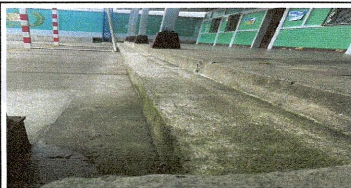
Sustitución de piso de concreto a piso cerámico, gradas color segovia cafés. 38 m2
