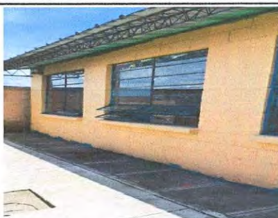
Sustitución de balcón en el módulo 3
