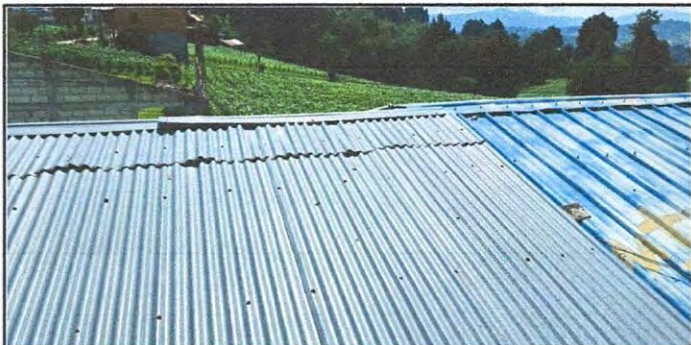
Suministro y aplicación de pintura antioxidante azul sobre lámina de módulo 2
