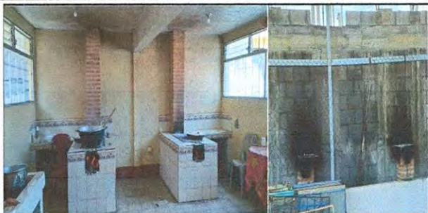
Mantenimiento de cocina, en plancha y chimenea Modulo 4
