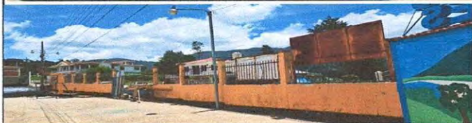
Suministro y aplicación de pintura exterior escuela celeste panton 293 para muros de fachada, panton 293 azul en zocalo, aplicación de pintura para interior de cocina color pastel
