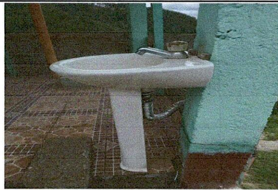
Sustitución de lavamanos por pileta tipo lavamanos.
