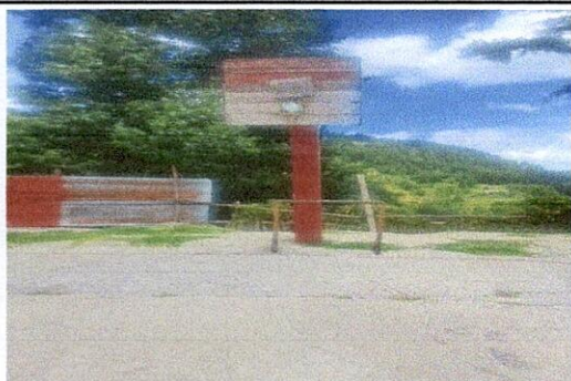
Sustitucion de estructura de area deportiva por estructura metalica de porterias con tablero para basquet-bol.
