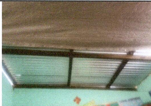
Mantenimiento correctivo con Sustitución de ciela falso en dos aulas.
