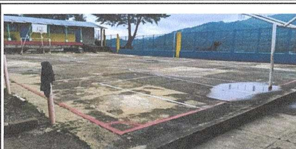
Reparacion de planchas de concreto de patio
