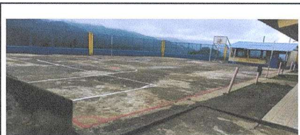
Reparacion de planchas de concreto de patio
