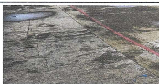
Reparacion de planchas de concreto de patio
