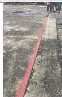
Reparacion de planchas de concreto de patio
