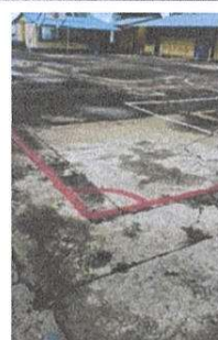
Reparacion de planchas de concreto de patio
