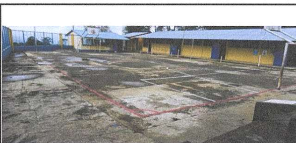
Reparacion de planchas de concreto de patio
