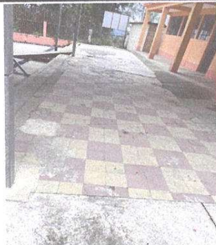
SUMINISTRO E INSTALACION PISO CERAMICO ESCENARIO
