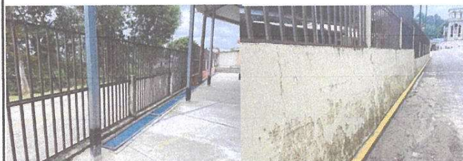
SUMINISTRO Y APLICACIÓN DE PINTURA DE BARANDA EXISTENTE
