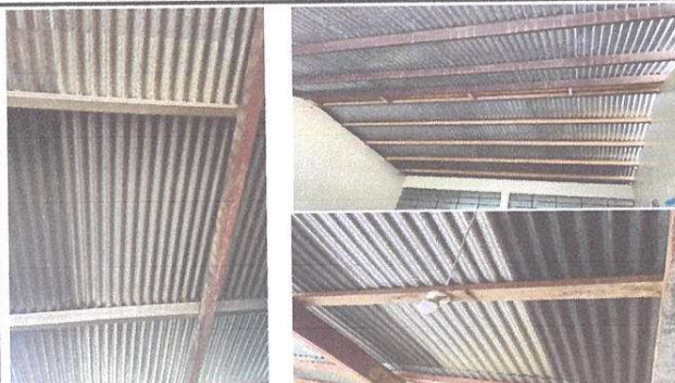
SUSTITUCION DE LAMINA DE 14 PIES TRASLUCIDAS
