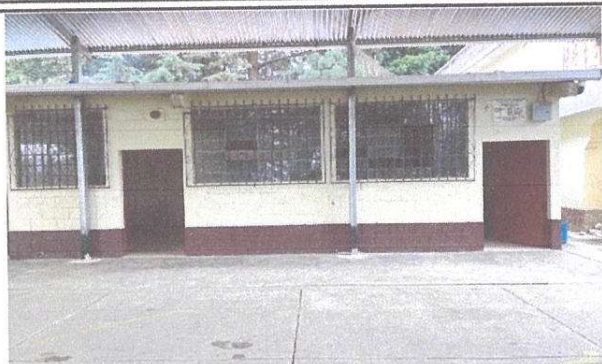
SUMINISTRO E INSTALACION VENTANA PVC
