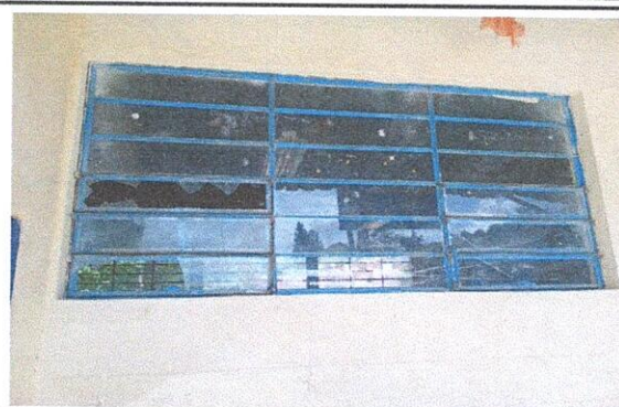
Fabricación de Balcones en módulo 2.
