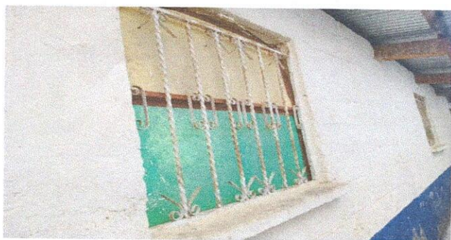
Sustitucion de Balcones en módulo 3.
