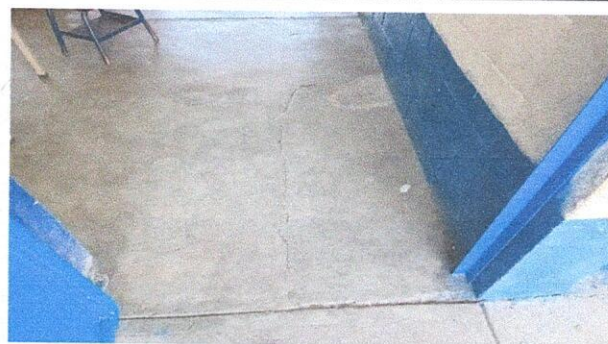
Sustitucion de Piso de torta a piso ceramico en aula.
